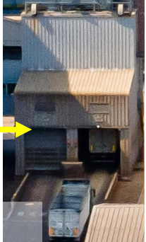
Poste de chargement tourteaux fermé
