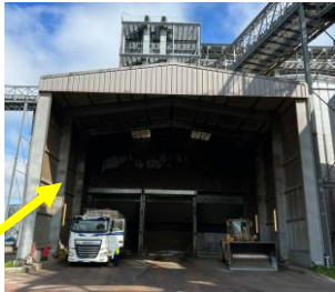
Poste de livraison
